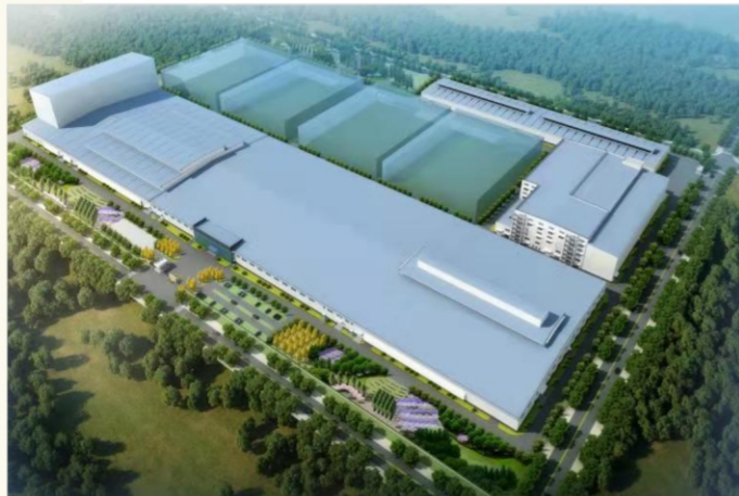
NHÀ MÁY CHẾ TẠO LỐP XE SAILUN SAILUN TIRE MANUFACTURING FACTORY Địa chỉ: KCN Phước Đông, Gò Dầu, Tây Ninh. Address: Phuoc Dong Industrial Park, Go Dau, Tay Ninh Chủ đầu tư: Công ty TNHH Sailun Việt Nam Investor: Sailun Vietnam Co., Ltd.
