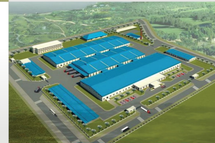
NHÀ MÁY TINH LỢI 3 프로젝트명: Tinh Loi 3 공장 Địa chỉ: CCN Nguyễn Giáp, Xã Nguyễn Giáp, Hải Phòng 위치: Nguyen Giap 산업클러스터, Hai Phong시 Chủ đầu tư: Công ty TNHH May Tinh Lợi 발주처: Tinh Loi 의류 유한회사
